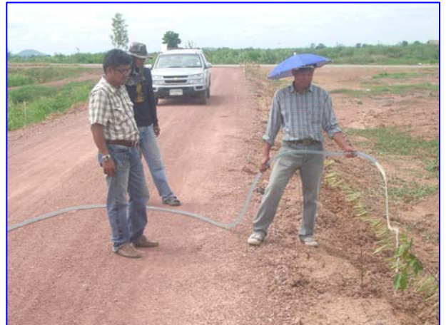
รอบอ่างเก็บน้ำโครงการแก้มลิงบ้านหัวดง หมู่ที่ ๘ ตำบลหัวดง อำเภอเมือง จังหวัดพิจิตร
